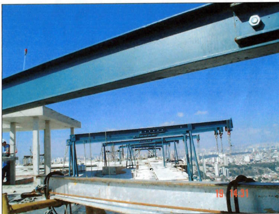
Fig. 31 – sistema de fixação de estrutura de sustentação dos andaimes suspensos
