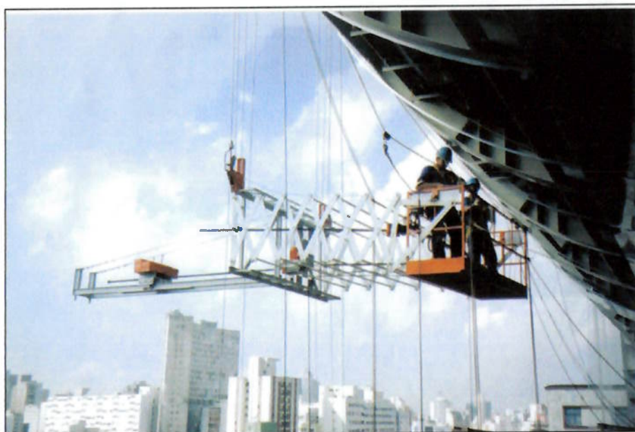
Fig. 29 – sistema telescópico para acesso (extendido)
