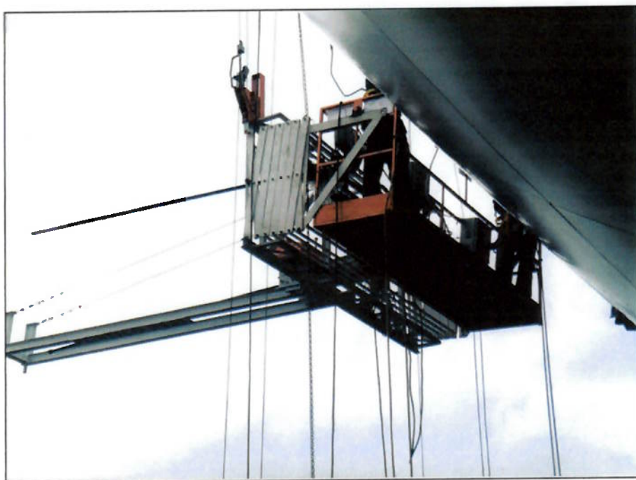
Fig. 28 – sistema telescópico para acesso (recolhido)
