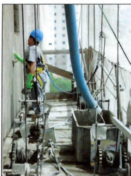
Fig. 8 – transporte de argamassa para o andaime suspenso
