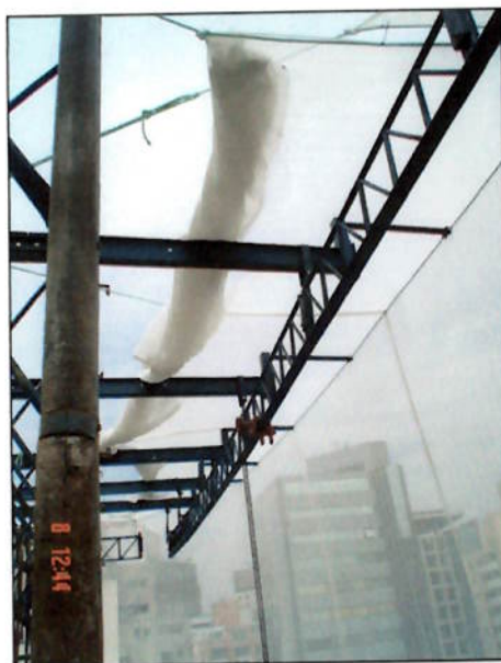
Fig. 27 – estrutura de sustentação de andaimes suspenso e tela de fachada
