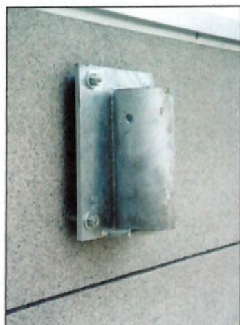
Fig. 21 – ponto fixo Fig. 22 – estrutura de sustentação de andaimes suspensos
