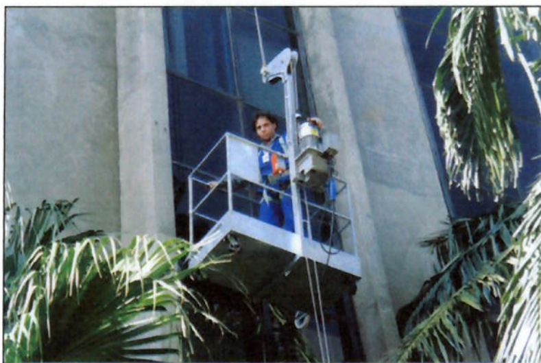
Fig. 12 – gôndola motorizada
