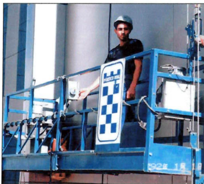
Fig. 7 – andaime suspenso motorizado
