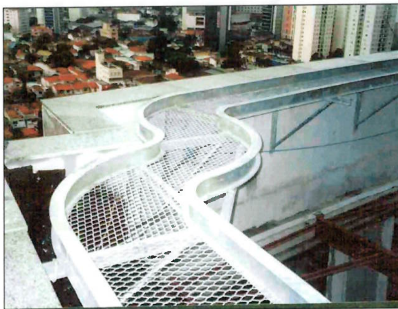
Fig.24 – estruturas para fixação de equipamentos de manutenção de fachadas
