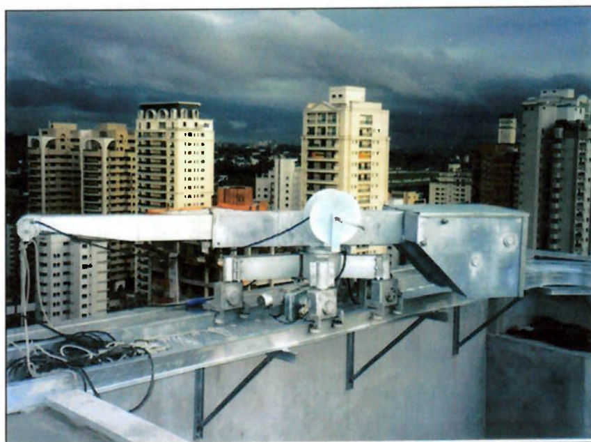
Fig. 25 – equipamento para manutenção com deslocamento horizontal
