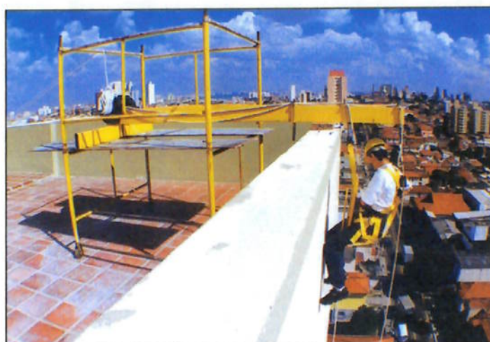
Fig. 18 – fixação de cadeira suspensa
