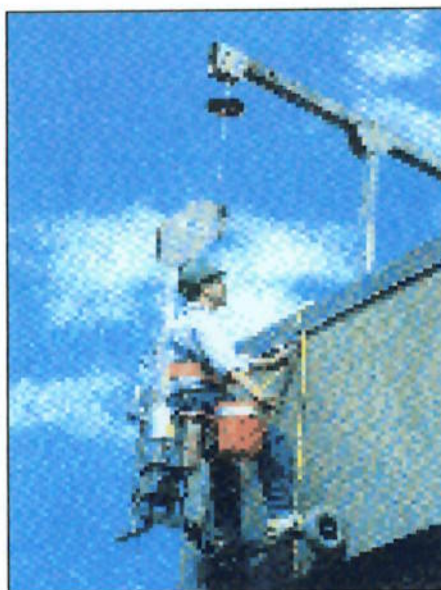
Fig. 10 – cadeira suspensa motorizada
