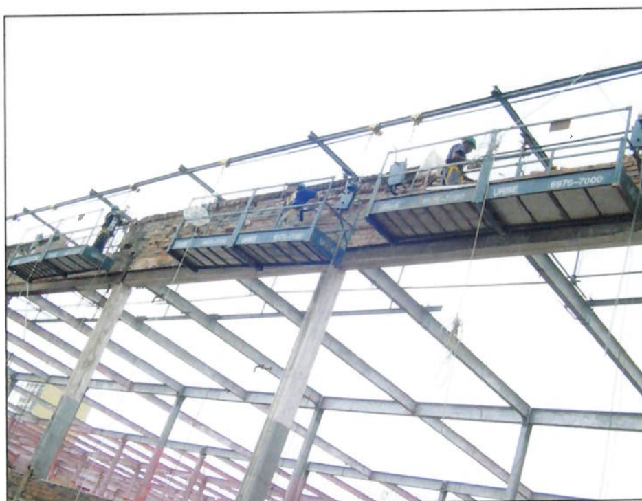
Fig. 33 – andaimes suspensos com trilho para movimentação horizontal
