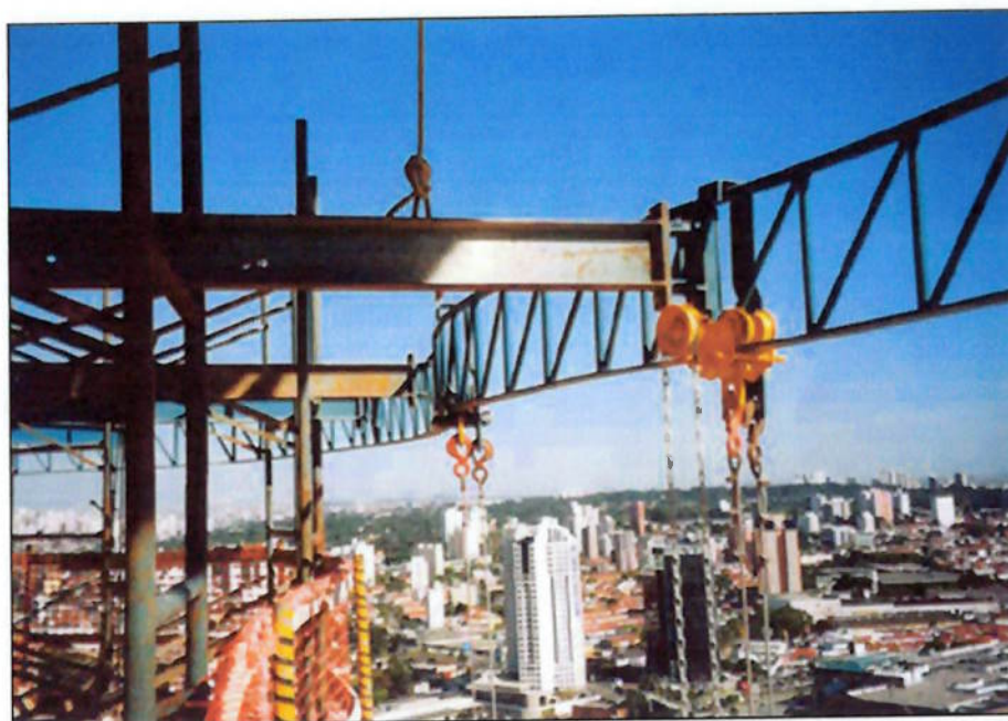
Fig. 32 – trilho para movimentação horizontal
