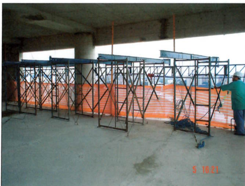
Fig. 13 – viga metálica apoiada sobre estrutura metálica presa à edificação
