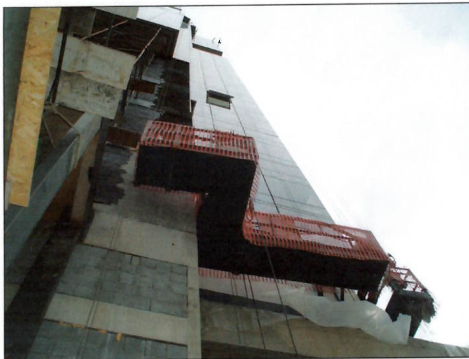
Fig. 30 – sistema de adaptação à geometria da edificação
