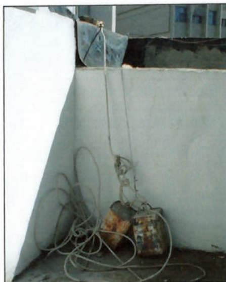
Fig. 19 – sistema de contrapeso inadequado
