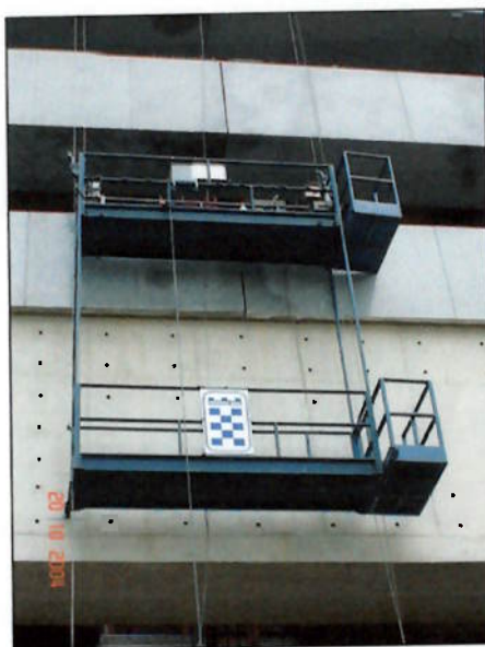
Fig. 26 - sistemas para trabalho na mesma projeção em alturas diferentes simultaneamente
